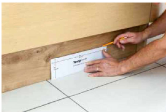
13. Přiložte šablonu k povrchu a označte ji perem s jemným hrotem.
