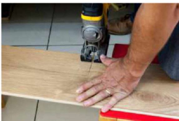
16. Pro odnímatelné kopnutí špičkou lze k vyříznutí otvoru použít přímočarou pilu.
