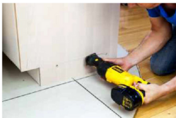
15. U pevných koncových panelů nebo pevných kopů lze k vyříznutí otvoru použít Sawzall.
