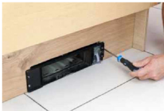
21. Přišroubujte na místo pomocí 4 šroubů do dřeva.
