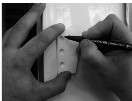
5 – Označte a vyvrtejte tři otvory Ø 9 mm
