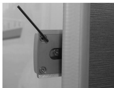
10 – Nasadte posuvník a poté Nerezový plech
